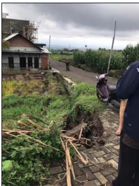
**Gambar 4. 51** Contoh Foto Saluran Irigasi Tersier Kondisi Rusak (T.Q7) di Kecamatan Batu
