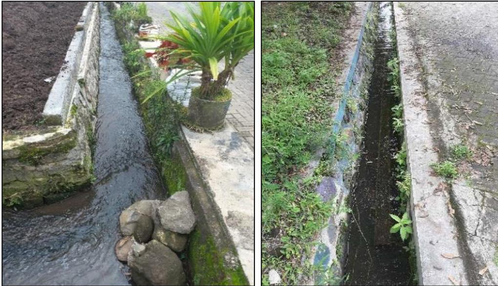
**Gambar 4. 68** Contoh Foto Saluran Irigasi Tersier Dengan Konstruksi Beton/Semen di Kecamatan Batu (T.R4 dan T.T2)
