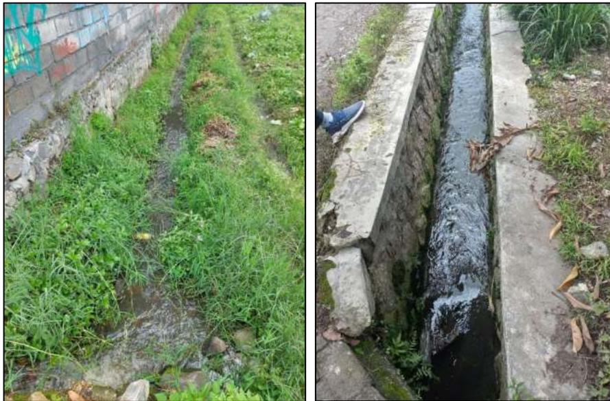
**Gambar 4. 38** Contoh Foto Saluran Irigasi Tersier Dengan Lebar 0,5 meter (T.U4 dan T.R1) di Kecamatan Batu
