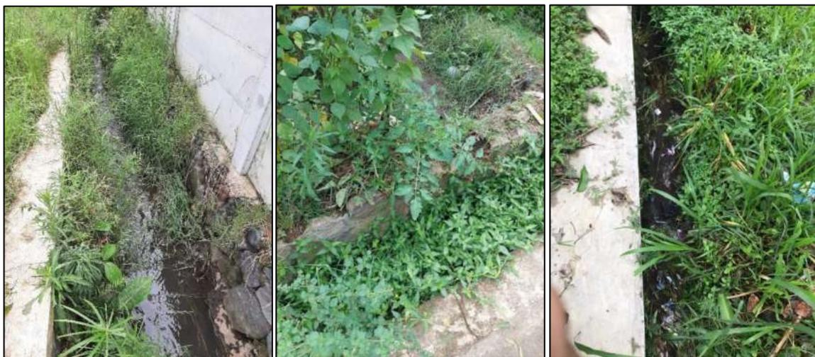
**Gambar 4. 50** Contoh Foto Saluran Irigasi Dengan Kondisi Kotor di Kecamatan Batu
