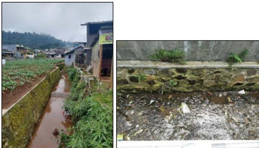
**Gambar 4. 41** Contoh Foto Saluran Irigasi Tersier Dengan Lebar 1,5 meter (T.I3 dan T.E3) di Kecamatan Bumiaji
