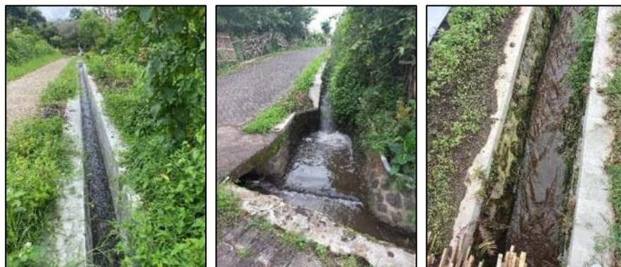
**Gambar 4. 57** Contoh Foto Saluran Irigasi Tersier Kondisi Berfungsi di Kecamatan Bumiaji (T.B18, T.A26 dan T.G2)
