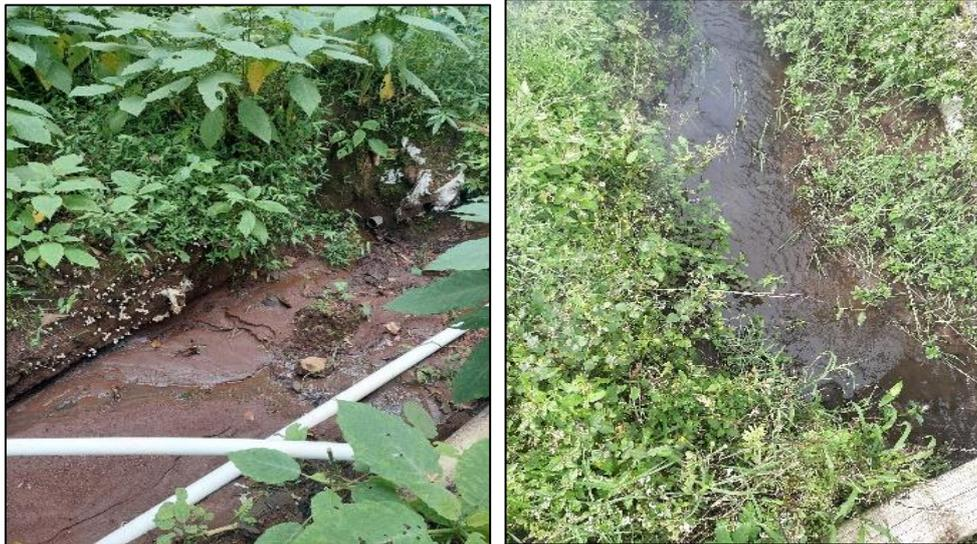
**Gambar 4. 71** Contoh Foto Saluran Irigasi Tersier Dengan Konstruksi Tanah di Kecamatan Bumiaji (T.I7 dan T.F2)
