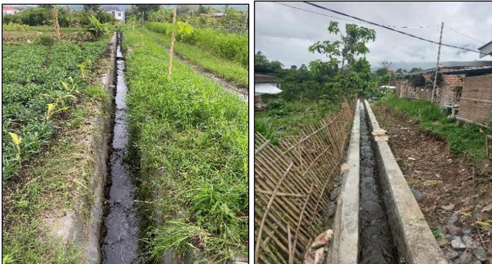
**Gambar 4. 72** Contoh Foto Saluran Irigasi Tersier Dengan Konstruksi Beton/Semen di Kecamatan Bumiaji (T.B4 dan T.A25)
