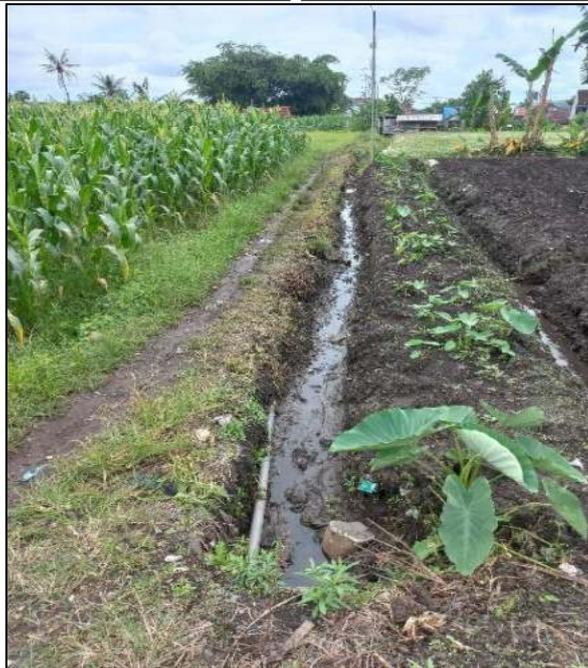
**Gambar 4. 76** Contoh Foto Saluran Irigasi Tersier Dengan Konstruksi Tanah di Kecamatan Junrejo (T.P8, T.O9 dan T.O11)
