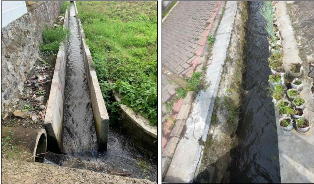
**Gambar 4. 77** Contoh Saluran Irigasi Tersier Dengan Konstruksi Semen/Beton di Kecamatan Junrejo (T.K2 dan T.O19)
