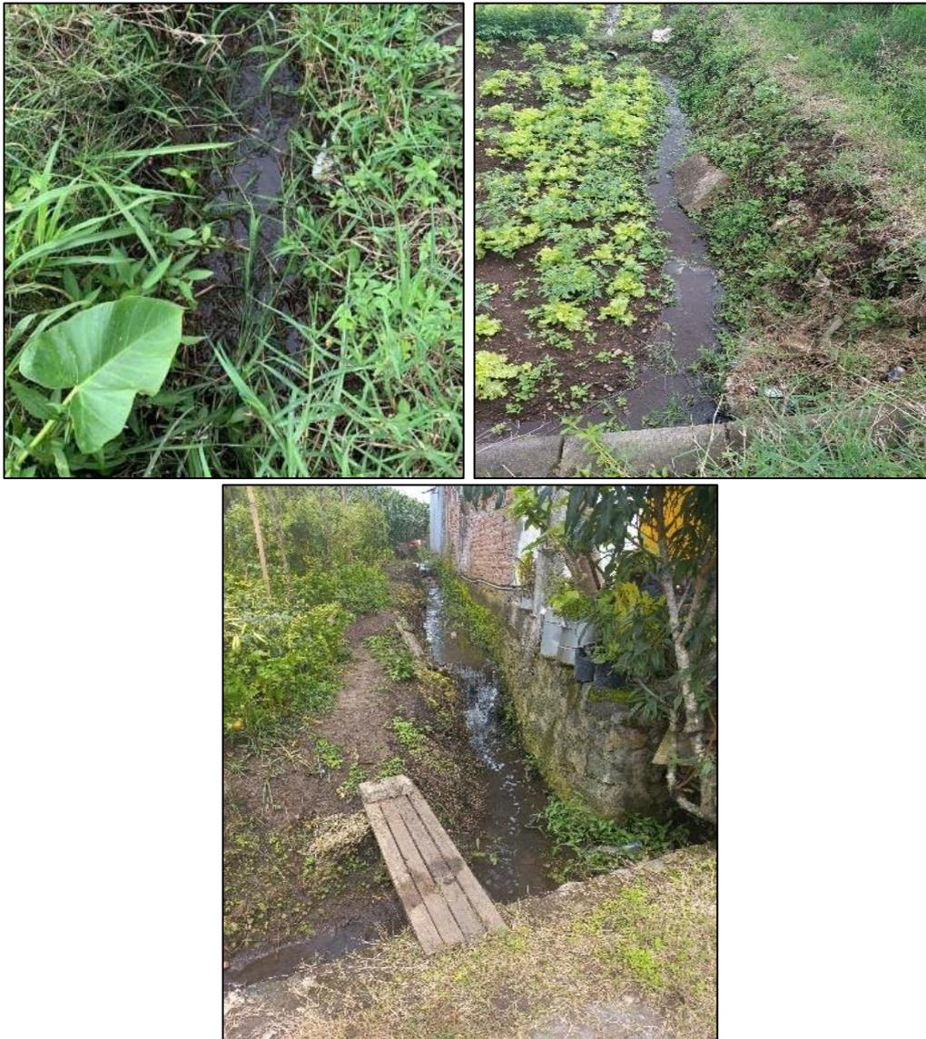
**Gambar 4. 67** Contoh Foto Saluran Irigasi Tersier Dengan Konstruksi Tanah di Kecamatan Batu (T.V1, T.U1 dan T.R2)
