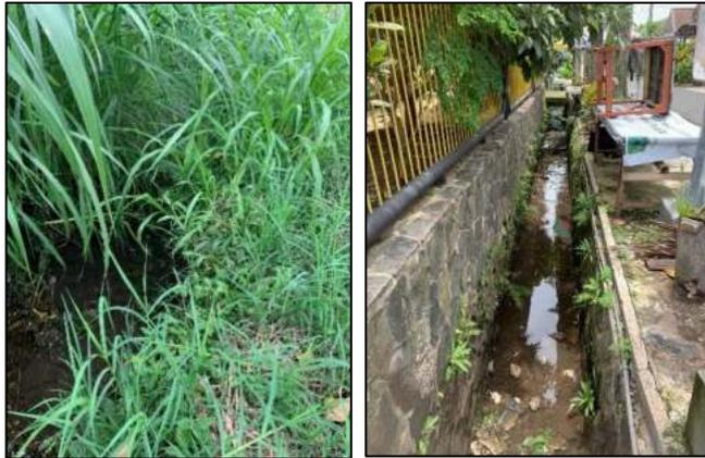
**Gambar 4. 60** Contoh Foto Saluran Irigasi Kondisi Kotor di Kecamatan Junrejo (T.K8 dan T.P7)
