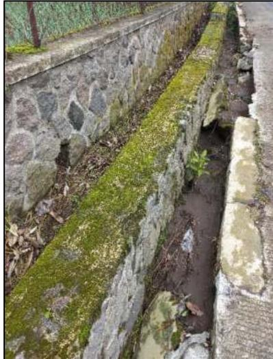
**Gambar 4. 42** Contoh Foto Saluran Irigasi Tersier Dengan Lebar <5 meter (T.B2 dan T.G6) di Kecamatan Bumiaji
